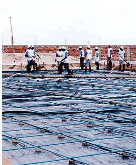
Figura 2: Radier Protendido
