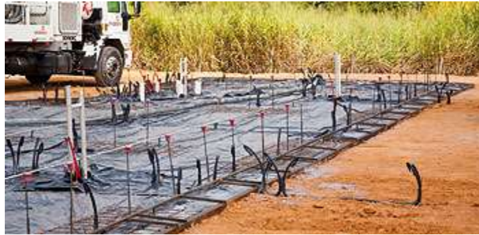
Figura 1: Radier Concreto Armado
