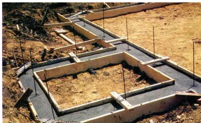
Figura 3: Sapata Corrida
