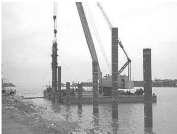
Figura 2 – Cravação do estaqueamento no mar (Lobo, 2003)
