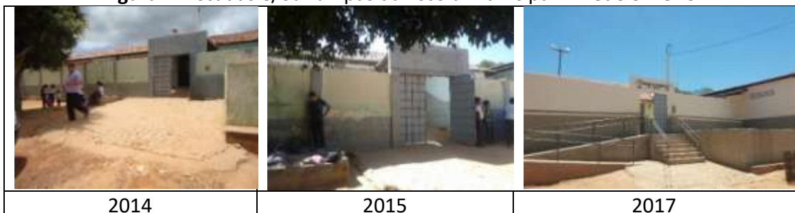
Figura 4: Escadas e/ou rampas da Escola Municipal Alfredo Silvério
