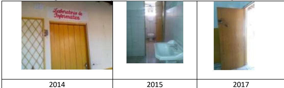
Figura 17: Portas e janelas da Escola Estadual 29 de Março
