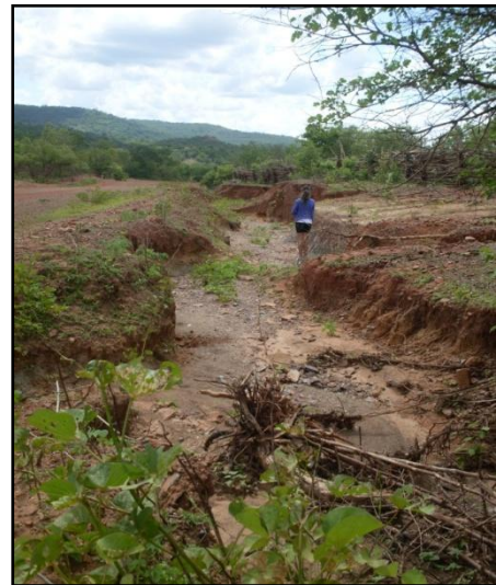
Figura 11- Exemplo de voçoroca no setor B Fonte: Santiago, 2014
